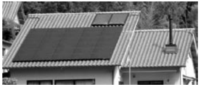
上の小さな2枚が集熱ユニット、下の大きな長方形が太陽光発電。右の屋根に出ているのは薪ストーブの煙突。
