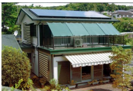
安田邸の南面。屋根に太陽光発電、2Fバルコニーに着脱式テント、1Fサンルームに巻上式テントを設置
